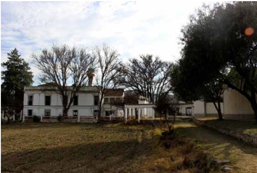
Villa Carmen, la antigua construcción
