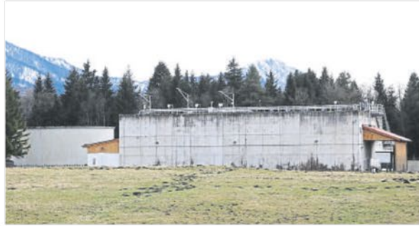
In diese Kläranlage an der B 472 leiten die Gemeinden Benediktbeuern und Bichl (Landkreis Bad Tölz-Wolfratshausen) und Sindelsdorf (Landkreis Weilheim-Schongau) seit fünf Jahren ihr Abwasser ein.
