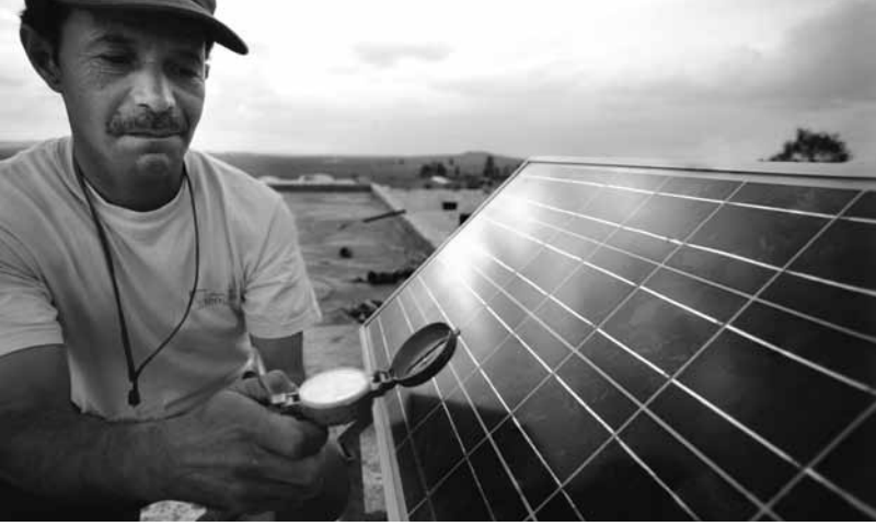
Ausrichtung eines Solarmoduls durch einen Techniker.
