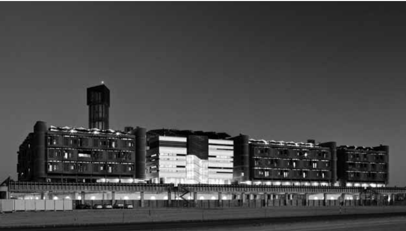
Das Masdar Institute of Science and Technology in der Wüste des Emirats Abu Dhabi soll zu einem Wissenszentrum für Erneuerbare Energien werden. Auch die Internationale Organisation für Erneuerbare Energien (IRENA) wird nach Masdar City umsiedeln.
