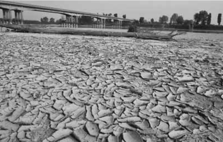
Der Pegelstand des Po lag im April 2007 6,5 m unter dem Normalwert.
