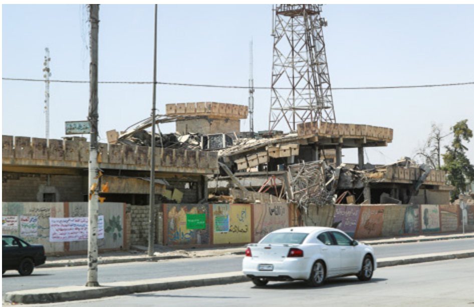
Zerstörtes Gebäude in Mossul
