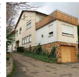
Ein Arztpraxis mit Wohnung, heute Herberge für mehr als 20 polnische Bewohner. Den Arbeitern wird es als „Hotel“ angepriesen. Foto: Gleichauf
