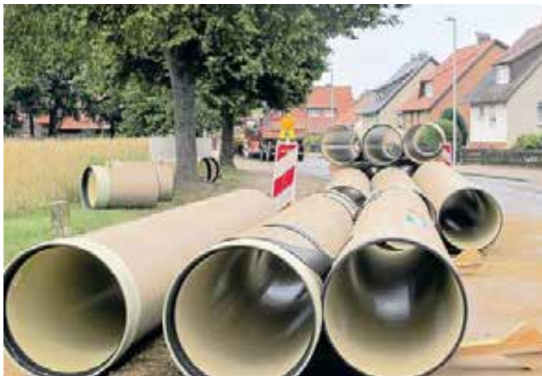
Anfang Juli 2014 wurde mit dem Kanalbau an der Peiner Straße begonnen.
