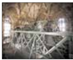
Der Glockenstuhl wurde von 2005 bis 2009 aufwendig saniert. Dafür mussten alle zehn Glocken abgenommen werden. Jetzt sind alle wieder an Ort und Stelle.
