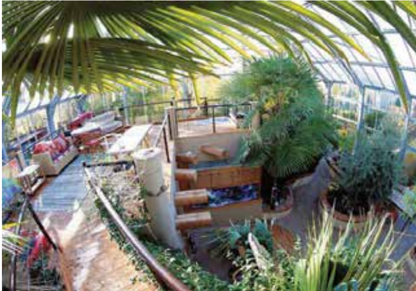
Der gläserne Überbau schützt die beiden Lehmhäuser von Martin Schuth vor Wind und Wetter. Die Temperaturen im Glasgebäude sind dadurch höher als draußen. Das wirkt sich positiv auf die Heizkosten aus. In dem milden Klima gedeihen zudem südliche Pflanzen wie Palmen, Bananen, Olivenbäume und Feigen. Fotos: Alexander Kaya
