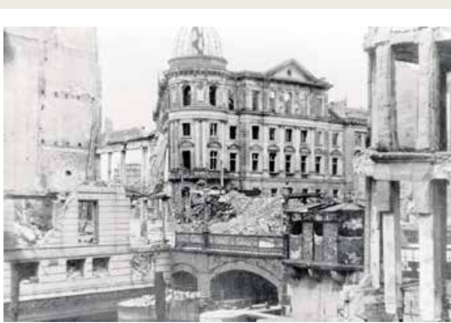
Das zerstörte Stadthaus und Brücke nach dem Ende des zweiten Weltkrieges. Viele Straßen waren schwer beschädigt. Doch U- und Straßenbahnen sollten rasch wieder ihren Betrieb aufnehmen. (Vatags Germany)
