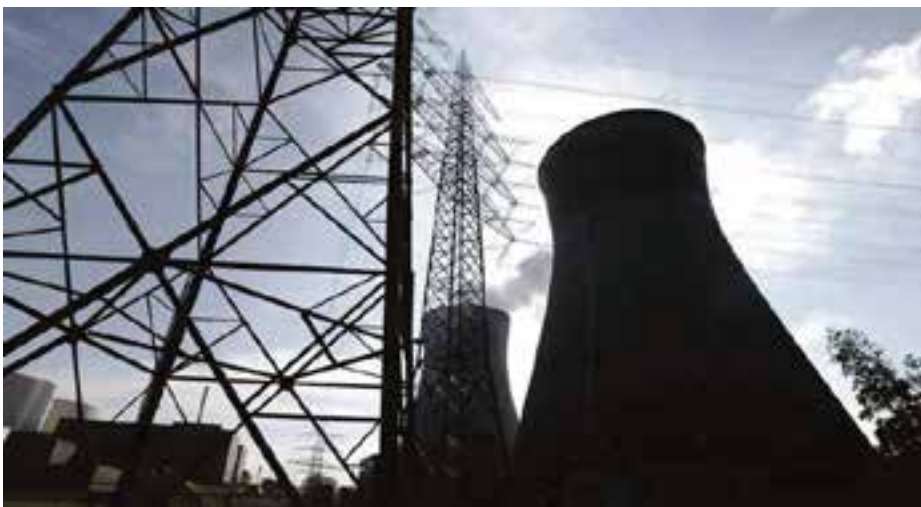
Noch arbeiten im Atomkraftwerk Gundremmingen viele Menschen, damit Strom produziert werden kann. Doch was passiert, wenn die Anlagen abgeschaltet sind und alles zurückgebaut ist?
