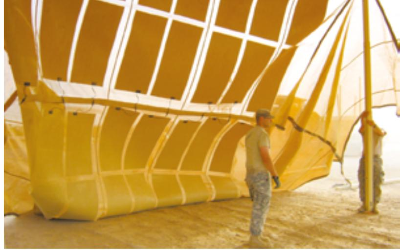
*Flexible Solarzellen auf Tarps der U.S. Army im Camp Lemonnier in Dschibuti. Die Einheit betreibt so Ventilatoren, Radios und Beleuchtung autark.*
